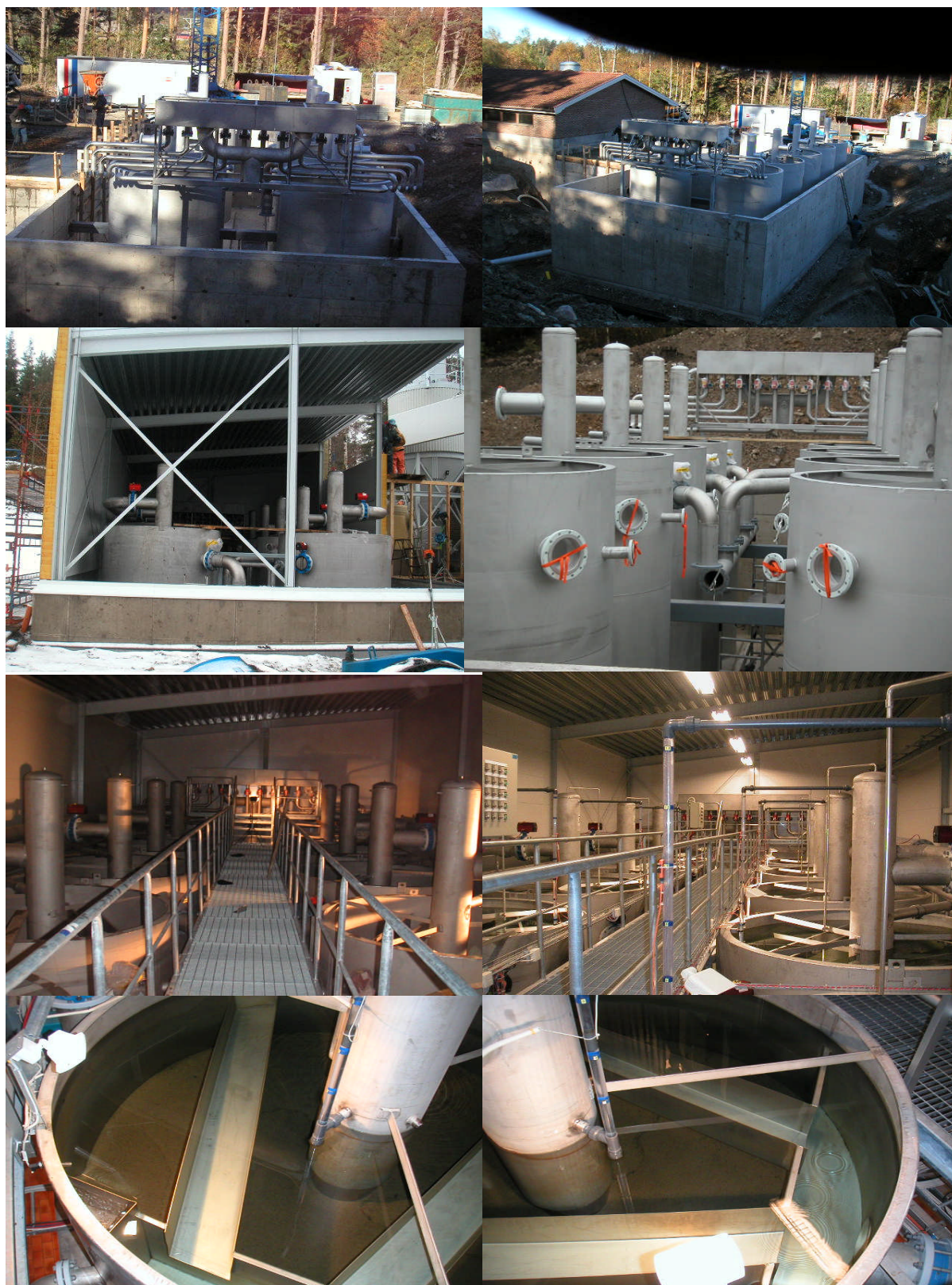
Bilder från byggandet av vattenverket i Tanumshede
